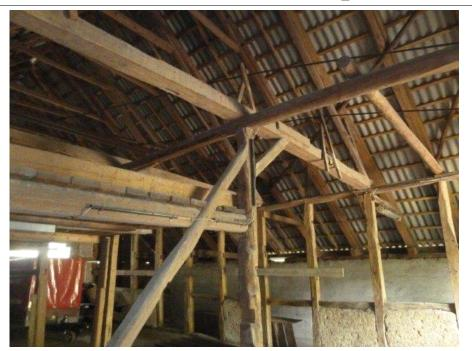
Die Dachkonstruktion ist ohne Verstärkung entsprechend heutiger Normen nicht für eine Pfannendeckung geeignet.
