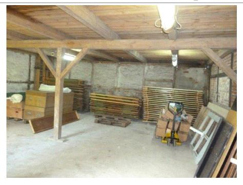
Die Dachkonstruktion wurde auf die Scheune aufgeschiftet .
