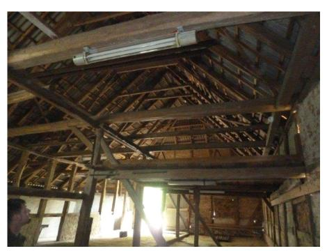
Der östliche Gebäudeteil ist ein späterer Anbau mit einem Kehlbalkendach und einer Holzständerkonstruktion. Auch in diesem Gebäudeteil sind Fachwerkaußenwände vorhanden.
