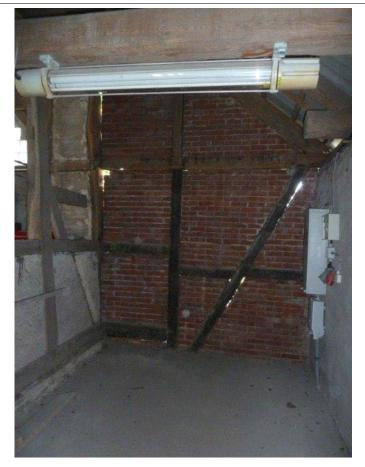
Im östlichen Giebel oberhalb des Tores ist ein massiver Defekt in der Fachwerkonstruktion vorhanden. Hier ist der Torriegel verrottet und droht durchzubrechen.
