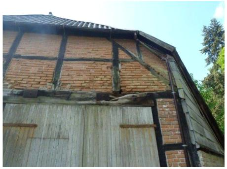
Eine Aussteifung des Giebels ist nicht vorhanden. Der Giebel ist nach hinten nachträglich über Zuganker verankert. Hierzu sind Stahlanker an den Torriegel angeschlossen worden.
