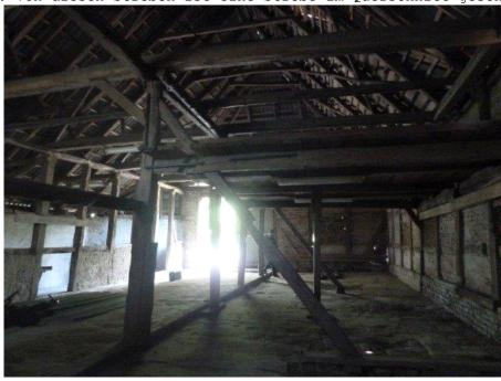
Die andere Diagonalstebe steht auf einem erhöhten Einzelfundament. In diesem Bereich können keine H- Kräfte aufgenommen werden. So dass auch hier die aussteifende Funktion nicht gegeben ist.
