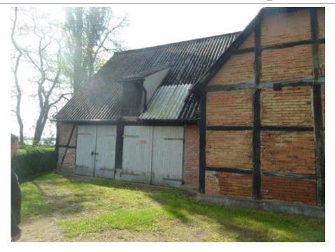
Der westliche Gebäudeteil ist eine alte Scheune mit einer tragenden Holzständerkonstruktion. Die Aussteifung der Scheune erfolgt über Diagonalstreben und Kopfbänder.
