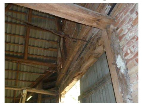
Die Zuganker sind im hinteren Drittel der Scheune an eingebaute Stahlträger angeschlossen worden. Die verwendeten U- Profile haben eine sehr geringe horizontale Steifigkeit und ein Verband ist nicht vorhanden, so dass die Zugverankerung und Aussteifung der Giebelwand quasi nicht gegeben ist.Der Giebel ist dadurch nicht standsicher.
