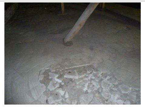
Im Tennenbereich sind vereinzelte Kopfbänder vorhanden. In Längsrichtung sind keine aussteifenden Elemente vorhanden.
